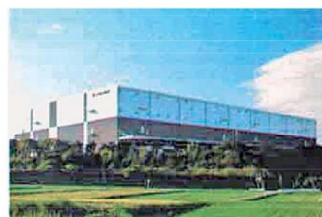
日本梱包運輸倉庫 愛知流通センター
