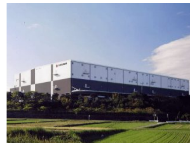
日本梱包運輸倉庫 愛知流通センター
